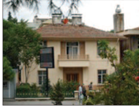
Fotoğraf 4. Orman İşletme Binası'nın yanında konumlanan lojman yapısının önden görünüşü
