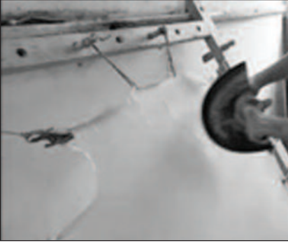
Şekil 2. Yarım daire ya da daire şeklinde kazıma bıçakları ve kazıma işlemi
