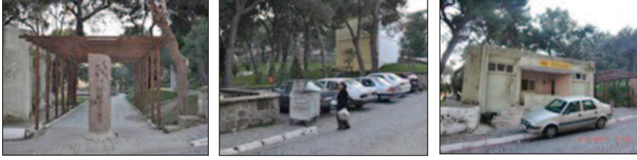
Şekil 4. Arkatlı giriş, otopark ve tuvalet binası
